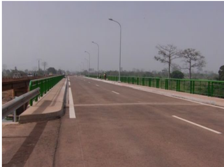
Photo 7 : Pont de Bouaflé © 2015
