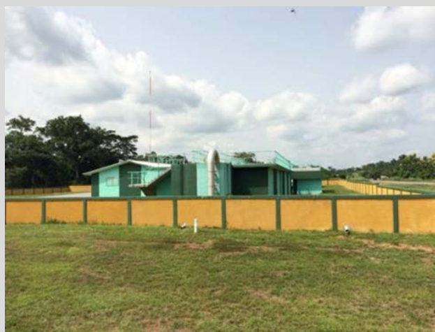
Photo 9 : Station de traitement d'eau potable – Man © 2014
