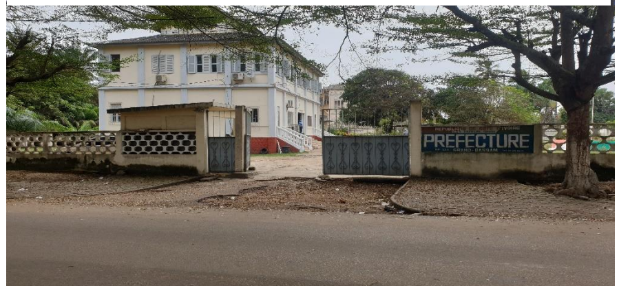
Photo 3: Préfecture de Grand-Bassam
