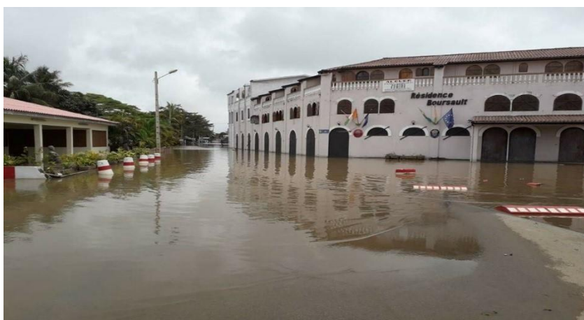
Photo 15: Inondations à Grand-Bassam
