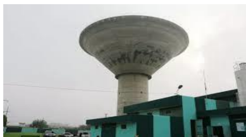
Photo 29: Château d'eau d'Angré
